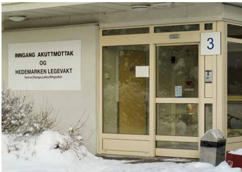
Det er relativt mange klage- og tilsynssaker fra legevakt i Hedmark. Legevakten for Hamar, Stange, Løten og Ringsaker (bildet) har tilhold i Sykehuset Innlandet HF – Hamar.
