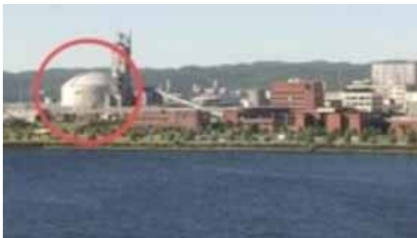
Ammoniaktanken på Herøya i Porsgrunn
